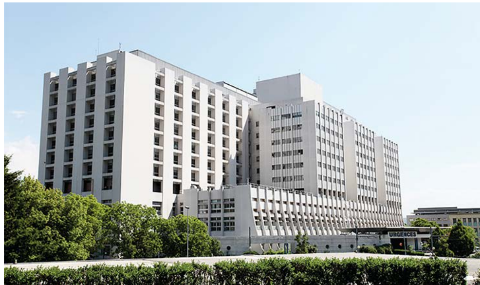
Centre Hospitalier Universitaire de Grenoble, France
